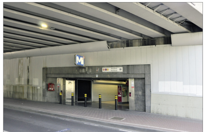
Metro access Maelbaek, Chaussee D'Etterbeek, level -2
